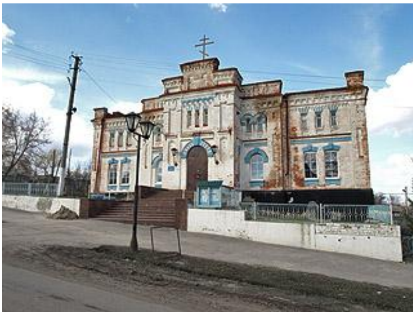
Старое здание храма. Пострадало от пожара.
